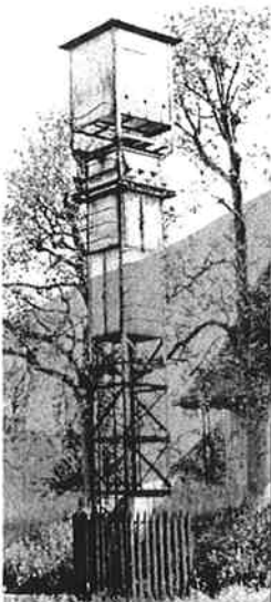
Mechanische Energieübertragung vom Kraftwerk Luterbach zur Zementfabrik Willhof
