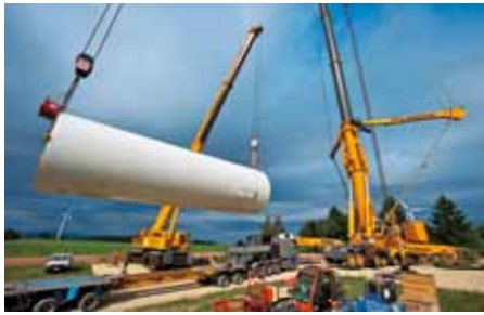
Mit Hilfe eines zweiten Krans wird das Turmelement vom Transporter gehievt und in die Senkrechte gebracht; den Rest verrichtet «Colossus» alleine.
