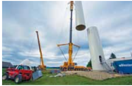
Mit Hilfe eines zweiten Krans wird das Turmelement vom Transporter gehievt und in die Senkrechte gebracht; den Rest verrichtet «Colossus» alleine.
